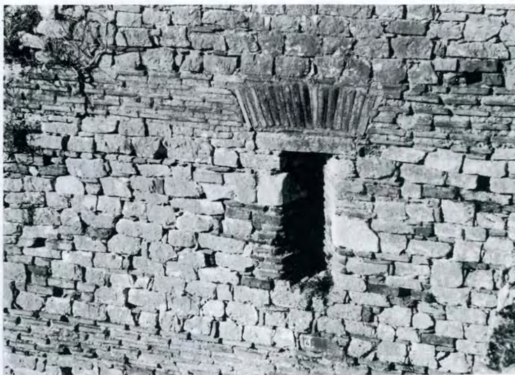
2. Nikopolis. Turm 19. Schartenschlitz, Feldseite
