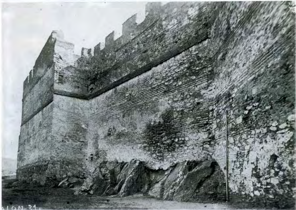
14. Thessalonike. Hormisdas – Mauer mit Ziegelbögen, Nordwestabschnitt
