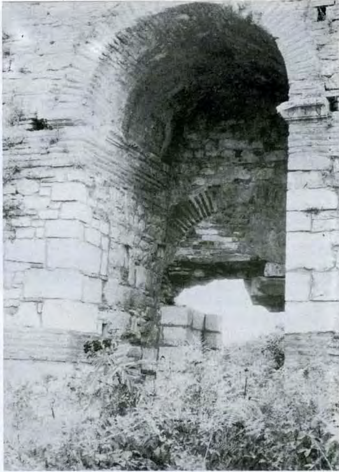
7. Nikopolis. Byzantinische Westmauer. Poterne, Stadtseite
