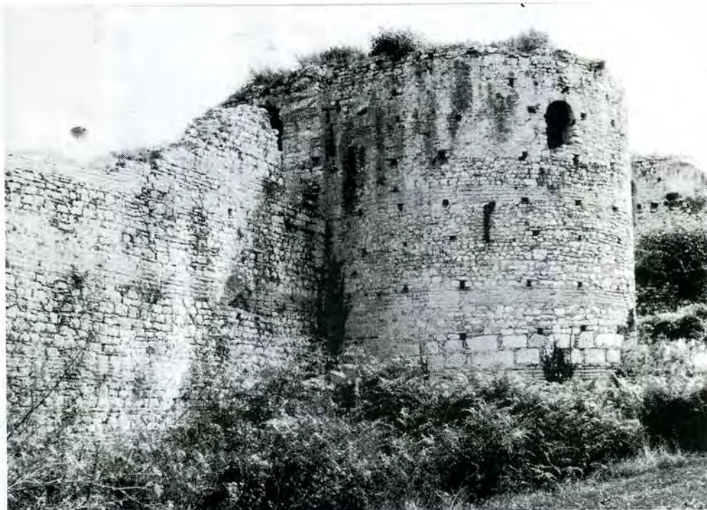
4. Nikopolis. Westtorbau, Turm 13
