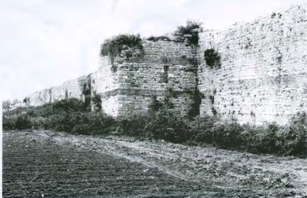
1. Nikopolis. Byzantinische Stadtmauer mit Turm 19 (Westseite)
