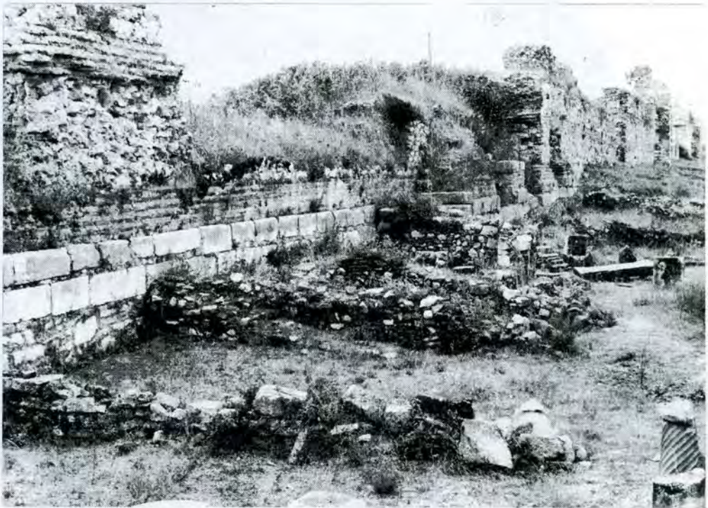
12. Nikopolis. Byzantinische Stadtmauer mit Hüttenbauten (Stadtseite)
