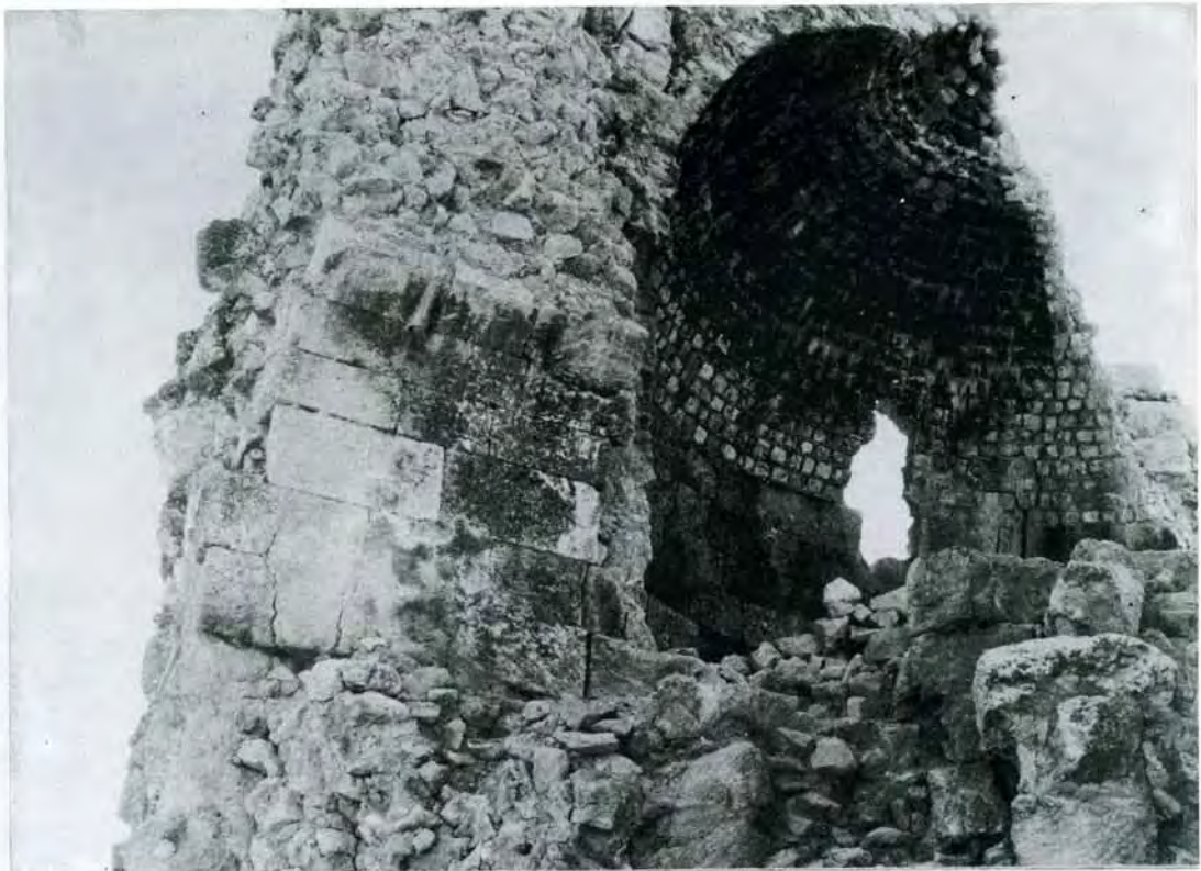
16. Daras. Gewölbter Halbrundturm, Nordseite
