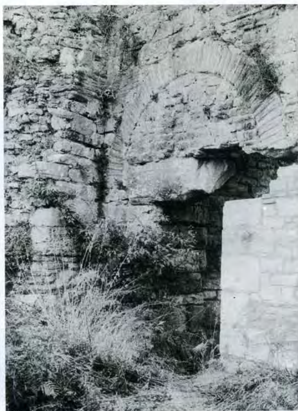
6. Nikopolis. Byzantinische Westmauer. Poterne, Feldseite
