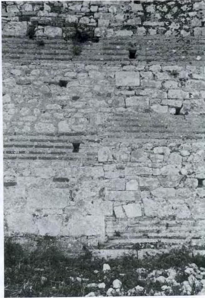
9. Nikopolis. Byzantinische Stadtmauer. Baunaht eines Arbeitsabschnittes
