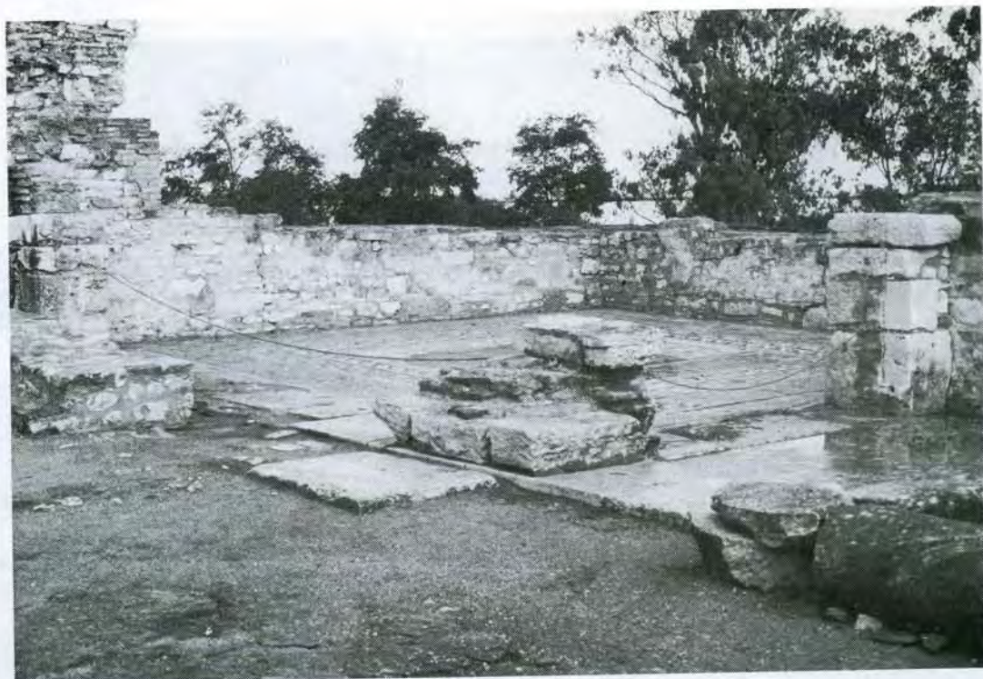
9. Βασιλική Α', το αυτό παστοφόριο μετά τις εργασίες αποκατάστασης
