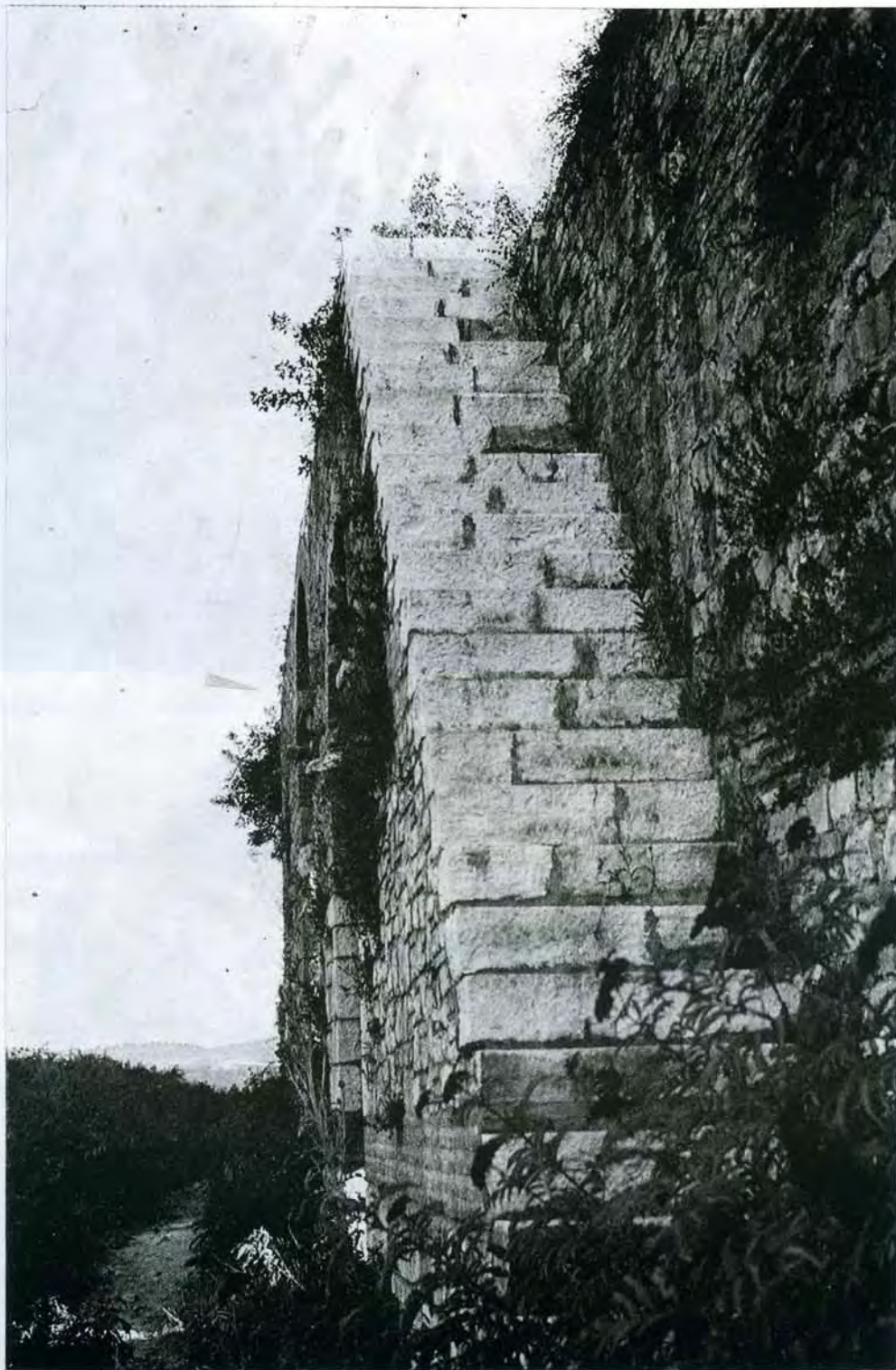
31. «Αναστήλωση» κλίμακας εισόδου στη νότια πλευρά των τειχών
