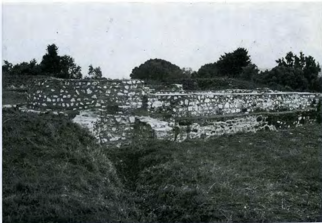
11. Βασιλική Α', το διακονικό μετά τις εργασίες αποκατάστασης
