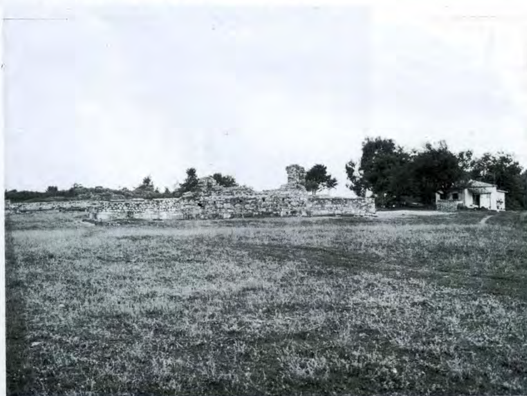
2. Βασιλική Α', άποψη από Α μετά τις εργασίες αποκατάστασης
