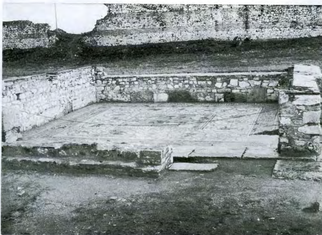
7. Βασιλική Α', το αυτό παστοφόριο μετά τις εργασίες αποκατάστασης
